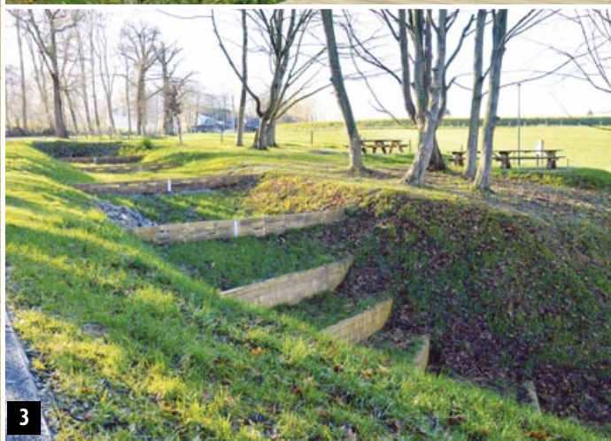
Foto's | 1 | Aanleg bekken met schotbalken. | 2 | houten vlonder aan Begijnhofplein in de vorm van meander. | 3 | Bekken op zuidflank met schotbalken.
