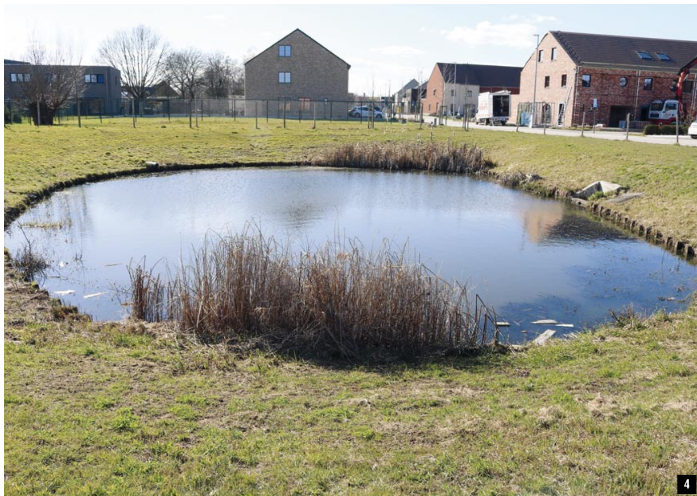
Foto's | 4 | Bestaande poel werd behouden en fungeert als buffer en infiltratiekom. | 5 | Zachte taluds en plasbermen binnen de verkavelingen in de winter.
