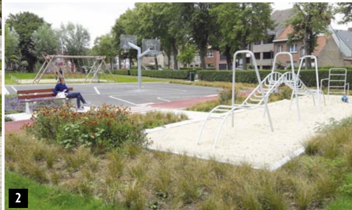
Foto's | 1 | Verlaagde speelzone (wadi) in combinatie met aanplant van bomen. 2 | Basketballplein met verlaagde plantvakken die fungeren als infiltratiestroken.
