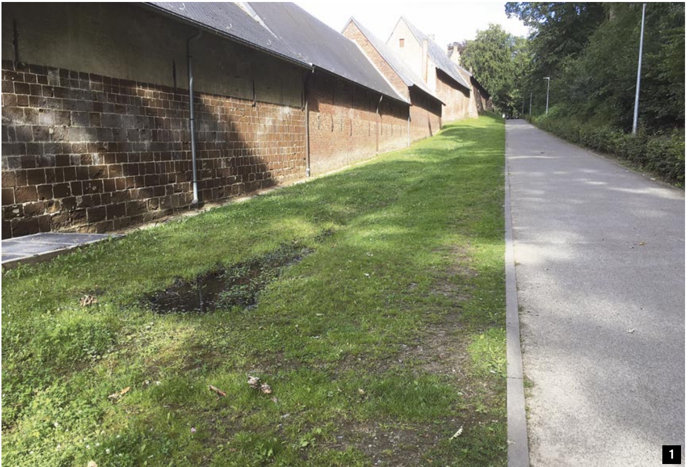
Foto | 1 | Infiltratiestrook langs fietspad .
