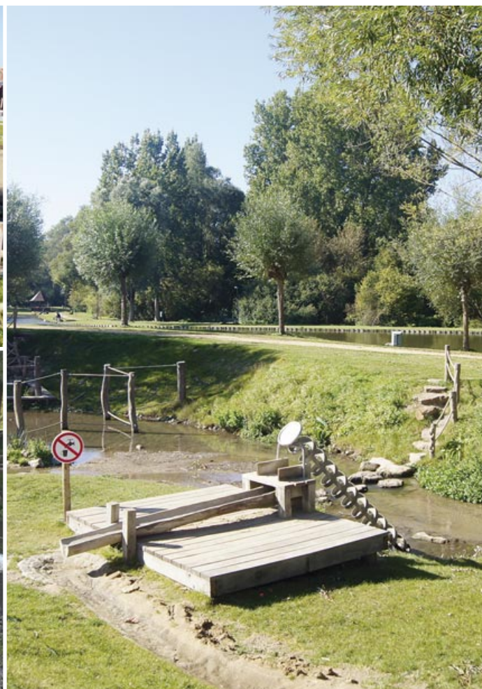
Foto's | 1 - 2 | De steile taluds werden afgevlakt en de bedding van de beek aanzienlijk verbreed om meer speelruimte te creëren.
