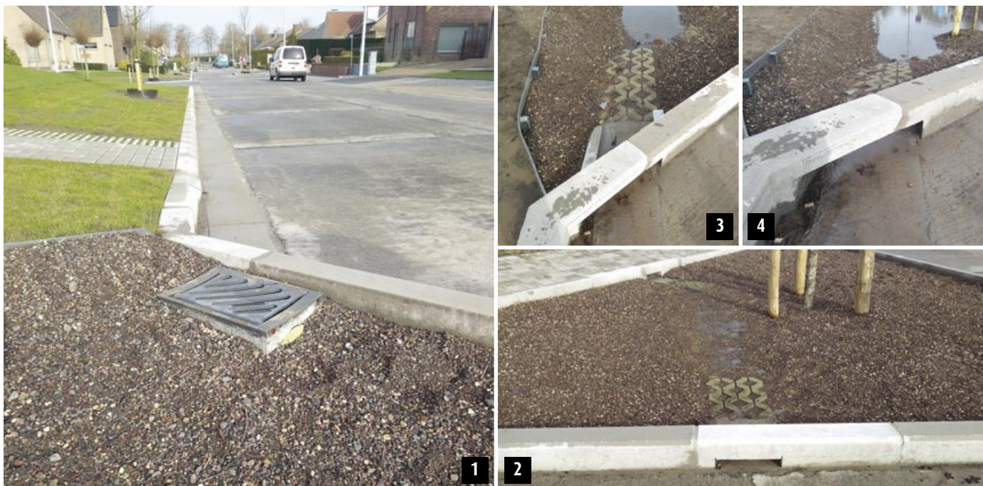
Foto's | 1 - 2 - 3 | Infiltratiestroken: de weg watert af naar de groenzones, die fungeren als wegversmalling en als wadi.
