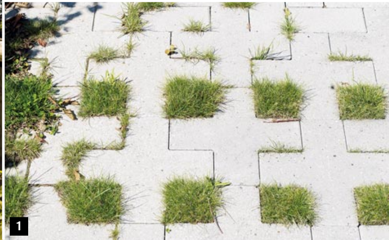
Foto | 1 | Detail van de grasbetonsteen, toegepast op de parkeerstroken.
