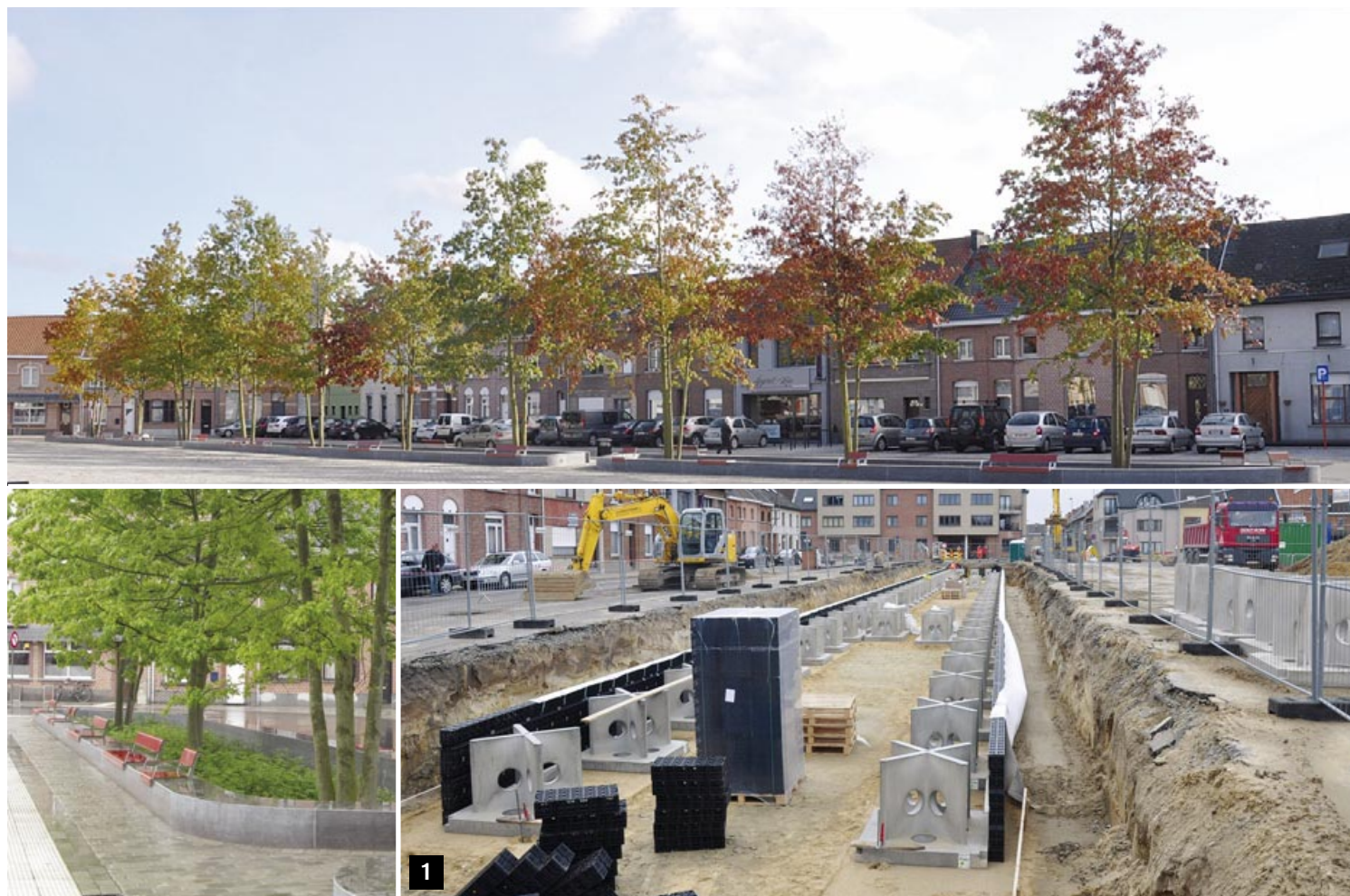
Foto | 1 | Aanleg Treebox.
