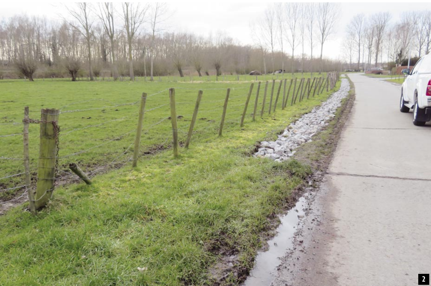
Foto | 2 | Drassige bermen aangelegd met grote keien in de diepte en de breedte voor een hogere opname capaciteit en een betere infiltratie.
